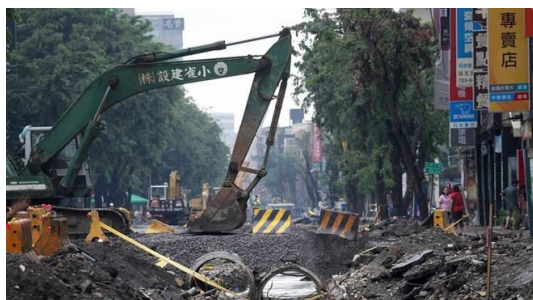
雨水下水道損壞示意圖
